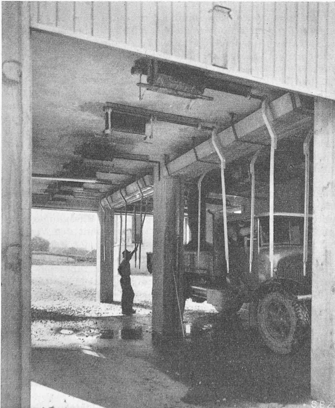
Bild 18. Siloverschlüsse (22) und Wasserabtropfrinnen Sämtliche Photos von Friebel, Sursee
