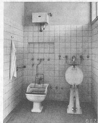
Bild 17. Ausguss und Steckbecken-Reiniger
