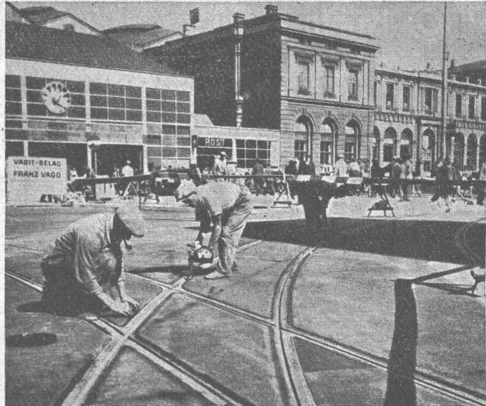
Umbau Bahnhofplatz, Einbauen von Fugenkitt PALTOX zwischen Tramgeleise und Strassenbelag
