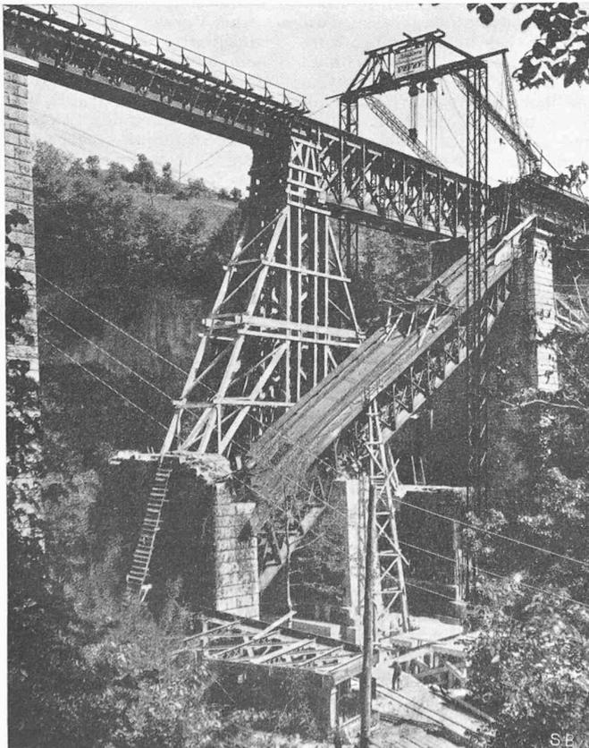
Bild 2. Beginn der Hebung des zweiten Trägers
