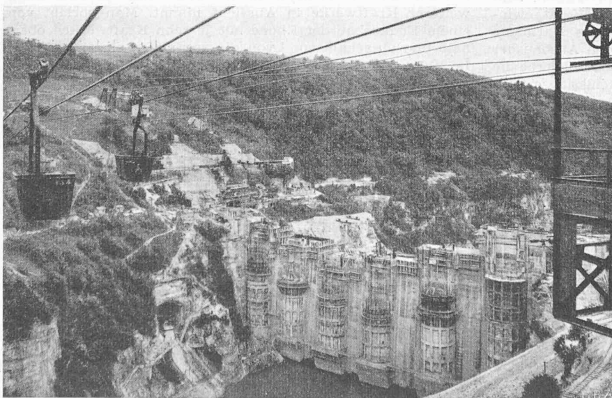
Bild 4. Oberwasserseite der Staumauer, linksufrig der Einlauf 10
