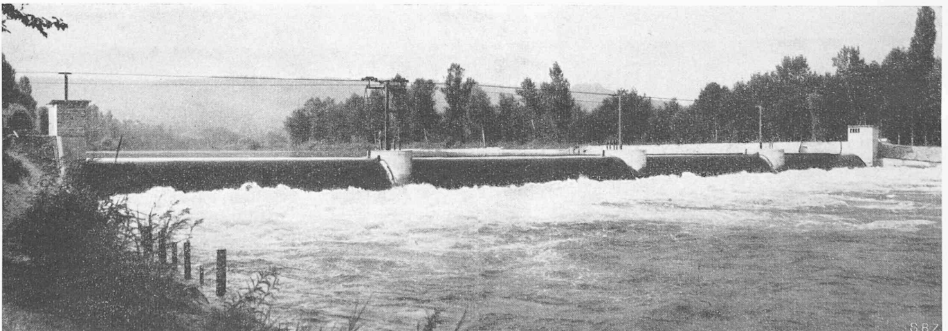
Bild 6. Neues Dachwehr in der Aare (System Huber & Lutz), für das Elektrizitätswerk Brugg, erbaut Mai 1943 bis Juli 1944 (Projekt und Bauleitung Ing. H. Blattner). Stauhöhe 2,50 m, fünf Oeffnungen zu 23,06 m, Seilbahn zur Bedienung der Regulierpfeiler und zum Einsetzen des Notverschlusses in Form eines eisernen Nadelträgers und hölzerner Nadeln. — Dieses Bild zeigt, wie die in Frage kommenden Bauwerke so gestaltet werden können, dass sie das Landschaftsbild nicht schädigen
