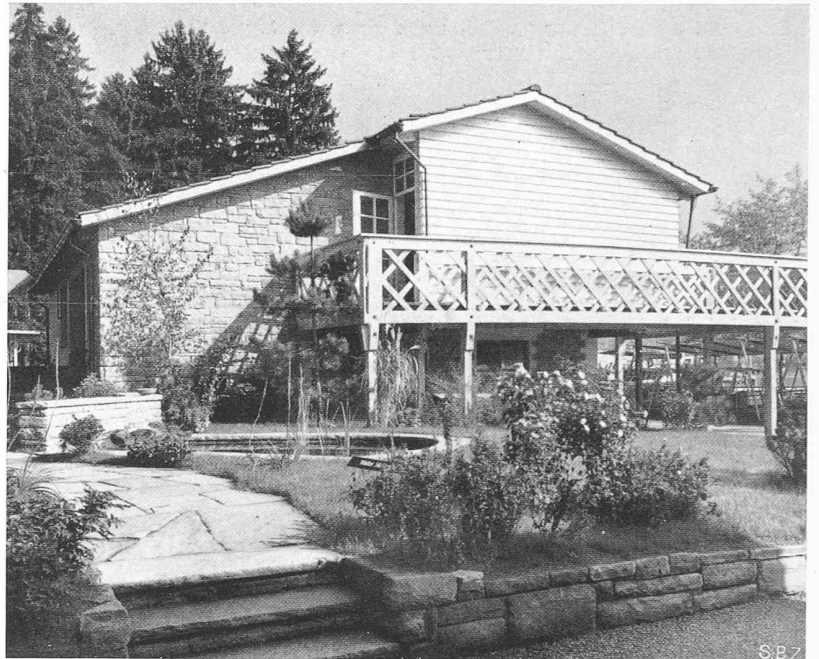
Bild 8. Musterhaus (Pläne u. Ausführung Alfred Altherr, Arch. BSA). Fertig erstellter Gebäudeteil; Brüstung des Besucherganges als tragendes Element (Ing. H. Lechner, Zürich)
