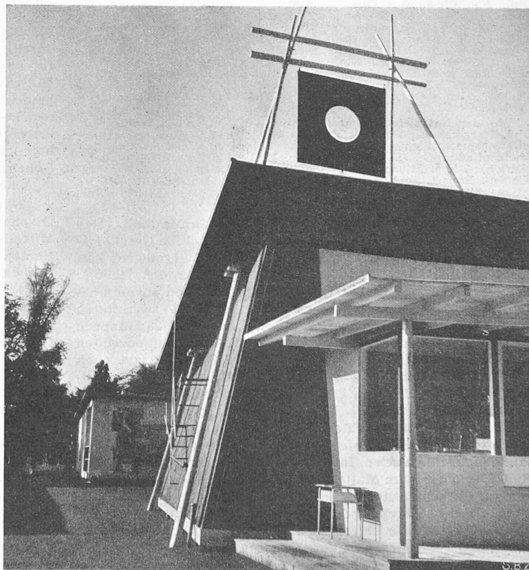
Bild 11. Ausstellungs-Kino. Vorführungskabine verglast. Die bock-artigen Rundholzstreben tragen die Dachscheibe und das Signet; die Seitenwände (diagonal verschaltete selbständige Scheiben) im Sinne eines Kartenhauses schräg zusammengestellt. Im Hintergrund Halle «Bekleidungs-gewerbe» mit Wandbild von Karl Hosch
