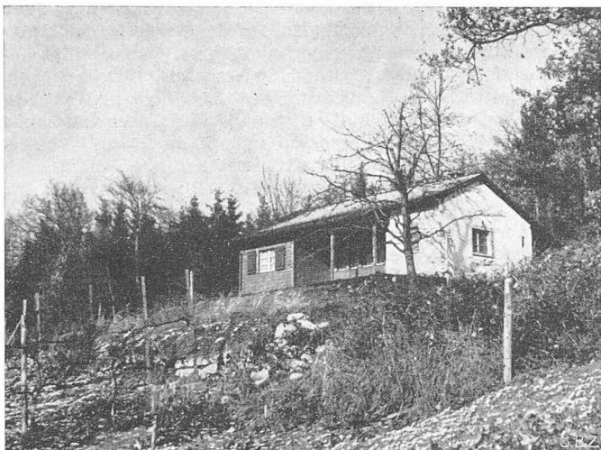
Bild 1. Ferienhaus M. in Hofstetten, aus Südosten
