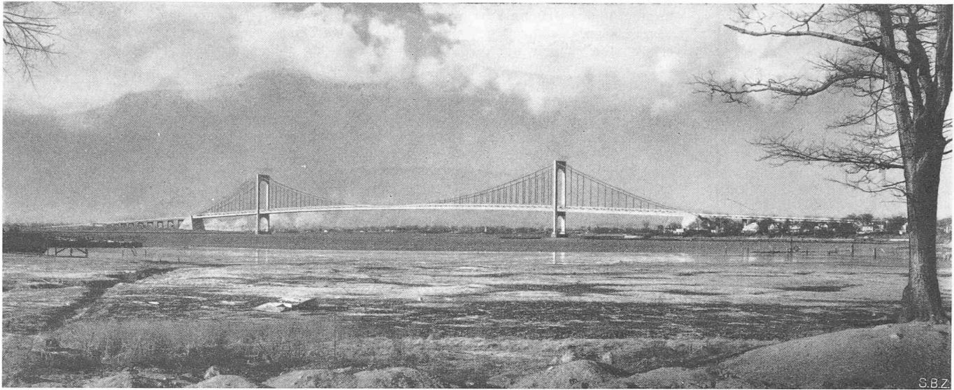
Bild 1. Die verstärkte Bronx-Whitestone-Brücke in New York (vgl. SBZ Bd. 115, S. 3, Bild 3)
