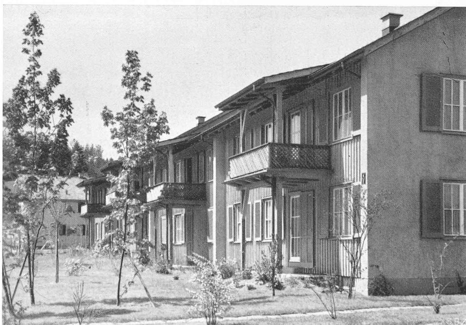
Bild 5. Einzelheiten der Holzbauweise (Stirnwände und Brandmauern massiv)
