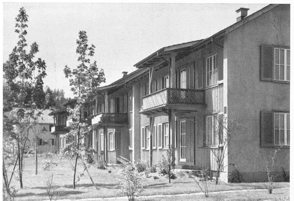
Bild 5. Einzelheiten der Holzbauweise (Stirnwände und Brandmauern massiv)
