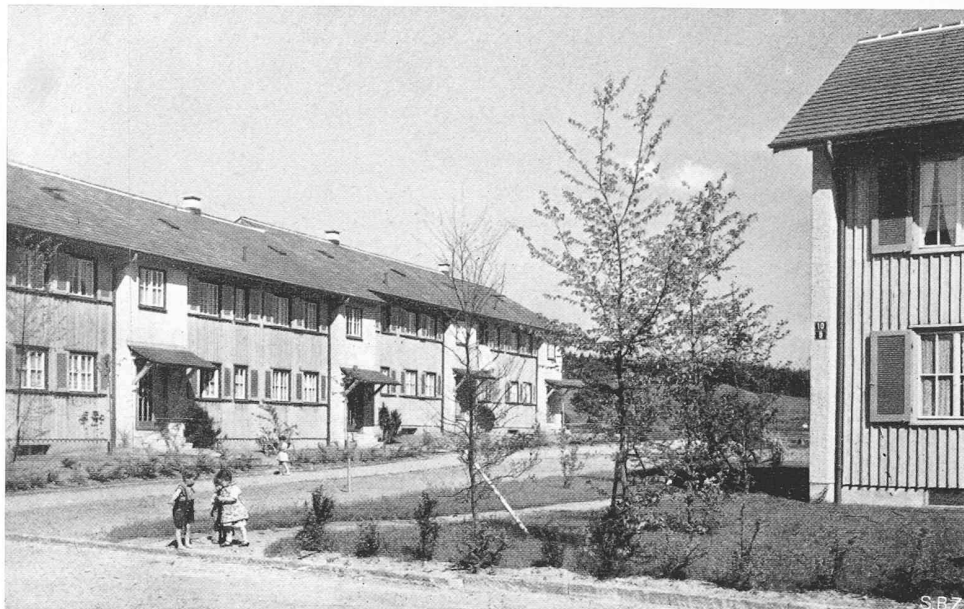
Bild 3. Siedlung im «Schachen». Nordostfassade der Häuser an der Buchackerstrasse
