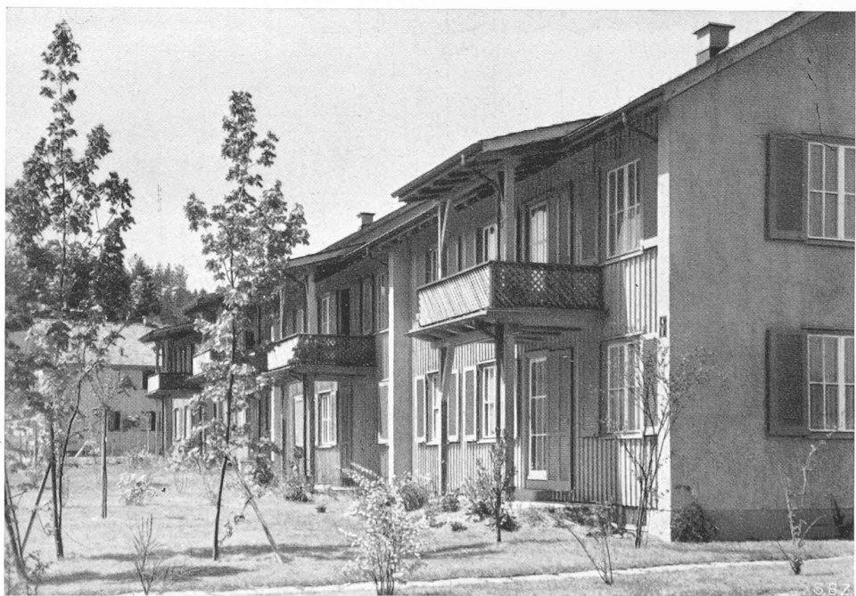
Bild 5. Einzelheiten der Holzbauweise (Stirnwände und Brandmauern massiv)
