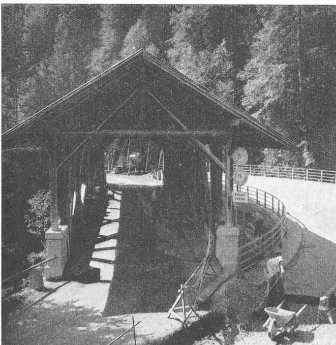
Bild 3. Alte Holzbrücke im Marchgraben
