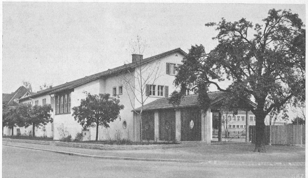
Bild 2. Ansicht aus Westen (Strassenseite)
