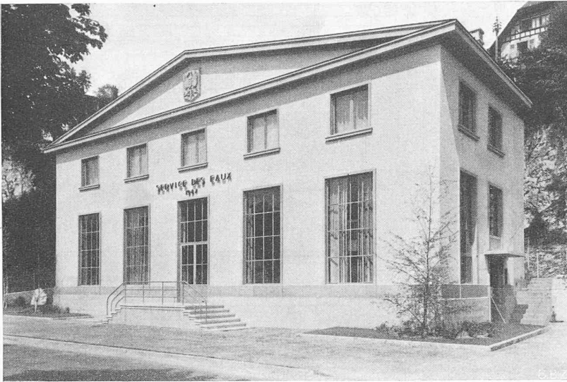
Bild 1. Das Seewasser-Pumpwerk der Stadt Neuenburg bei Champ-Bougin. Die neue Filteranlage befindet sich im nicht sichtbaren Anbau auf der Bergseite
