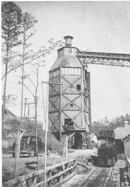
Bild 23. Betonieranlage, sechseckig, 33 m hoch, mit Förderband für Materialzufuhr. Drei Mischer zu je 2 m 3 mit Entleerung in der Gebäudeaxe
