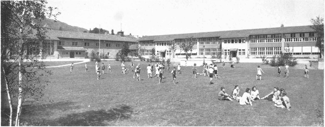
Spielwiese aus Südosten, links Turnhallenflügel an der Balberstrasse, rechts Klassenzimmertrakt
