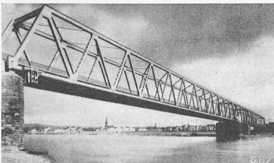
Bild 10. Rheinbrücke bei Neuwied
