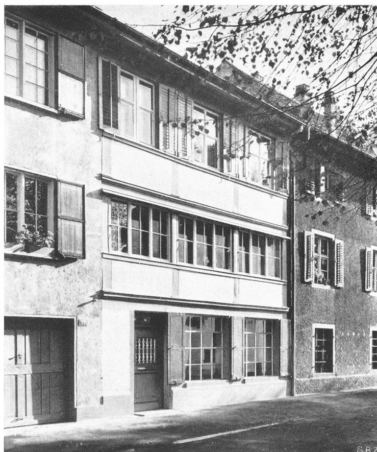
Bild 7. Haus 39 am Oberen Rheinweg in Basel
