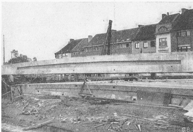
Fig. 5. Smets, poutres en dépôt
