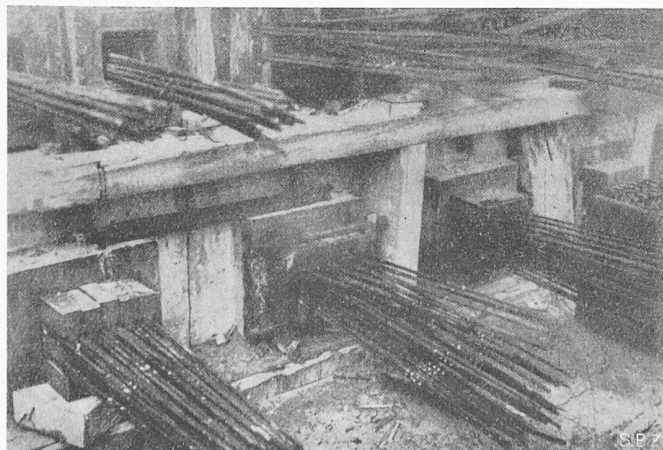
Fig. 4. Abouts des poutres avec câbles
