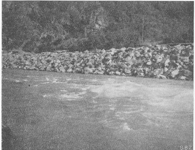
Blick 19. Rhonekorrektur. Sicherung der Ufer durch eine Blockschüttung mit der Neigung 2: 3
