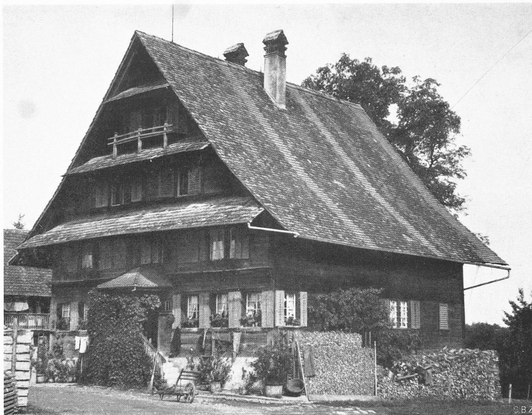
Ständerhaus in Mettmenstetten, Kt. Zürich
