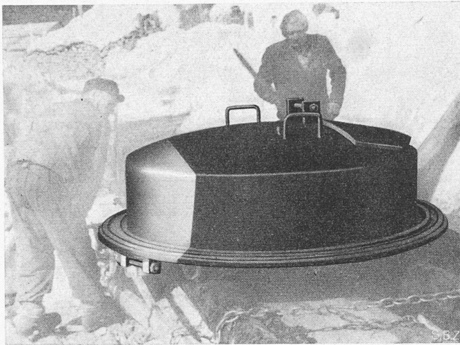
Bild 7. Als Schwimmkörper ausgebildeter Abschlussdeckel
