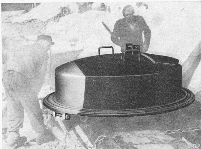
Bild 7. Als Schwimmkörper ausgebildeter Abschlussdeckel
