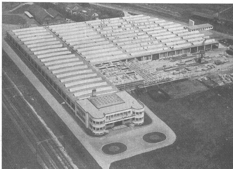
Traktoren- und Motorenwerke H. Hürlimann, Wil - Erweiterung 1946—1949, Flachbedachung 10 000 m 2 Bauleitung: F. Vogt, Architekt, Wil — Bauunternehmung: Ed. Züblin & Cie. A.-G., Zürich
