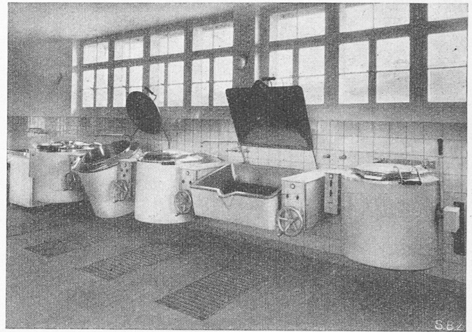
Bild 51. Elektrische Kippkessel-Anlage
