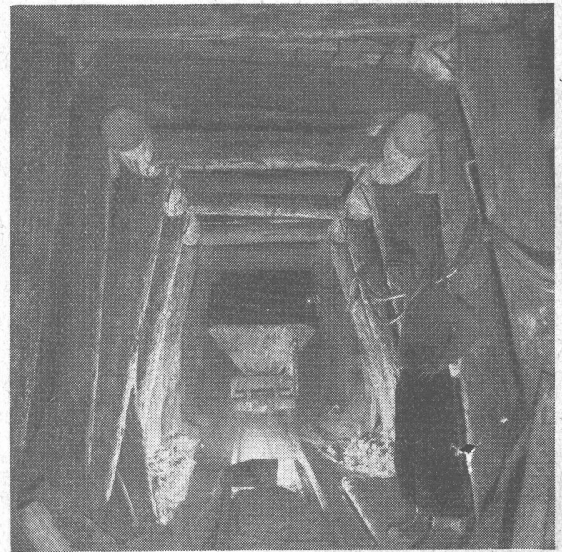
Stollen mit schwerem Einbau
