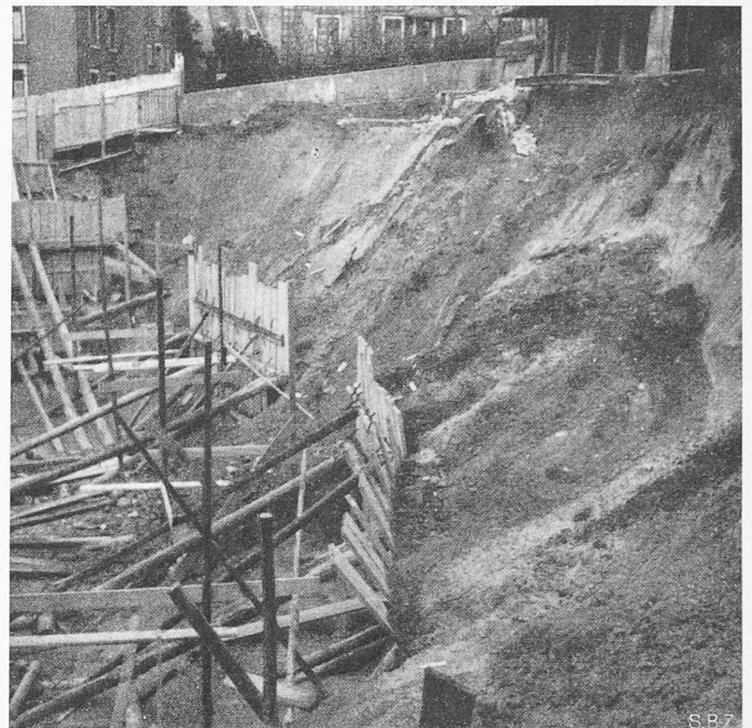
Bild 2. Zustand der Baugrube am 10. Januar 1948
