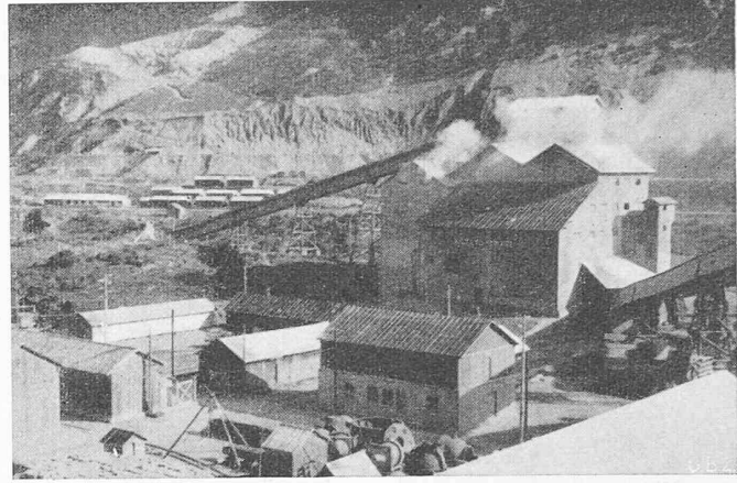
Bild 4. Teilansicht der Baustelle S. Giacomo di Fraële; im Hintergrund: Rolloch und offener Steinbruch, von dort Transportbandanlage zur Brech-, Sortier- und Waschanlage des Beton-Materials. Von da zweigen fünf verschiedene Transportbandanlagen zu den Deponien der fünf verschiedenen Kornkomponenten ab (eine davon sichtbar)
