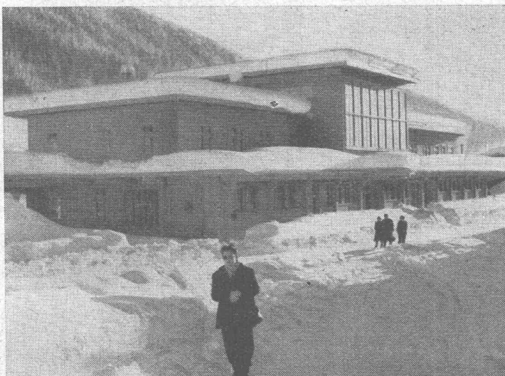
Umbau Bahnhof Davos-Platz Rh. B. Architekt Rud. Gaberel, BSA. Davos-Platz
