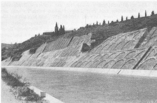
Bild 30. Kraftwerke Medio Adige: Kanalstrecke Ala-Bussolengo mit Hangverbauungen
