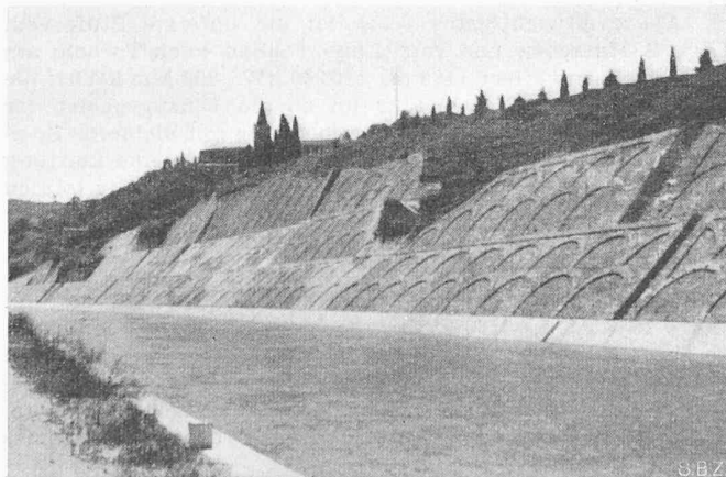
Bild 30. Kraftwerke Medio Adige: Kanalstrecke Ala-Bussolengo mit Hangverbauungen
