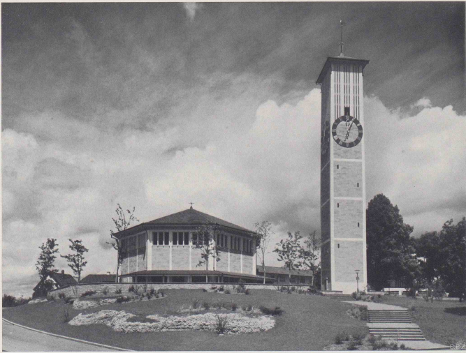
Blick und Zugang von Süden
