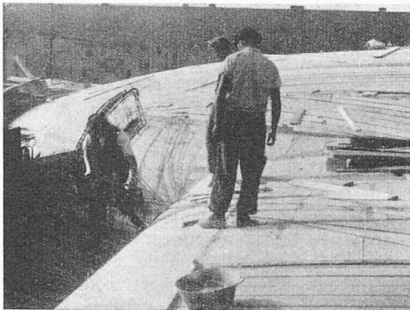
Bild 17. Aufbringen der Kuppelschalung durch natürlich gebogene Schalbretter
