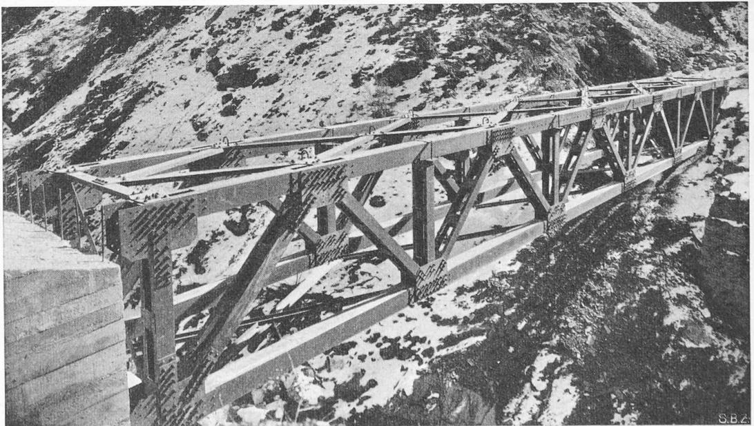
Bild 2. In Südfrankreich montierte Behelfsbrücke System Seibert, Saarbrücken
