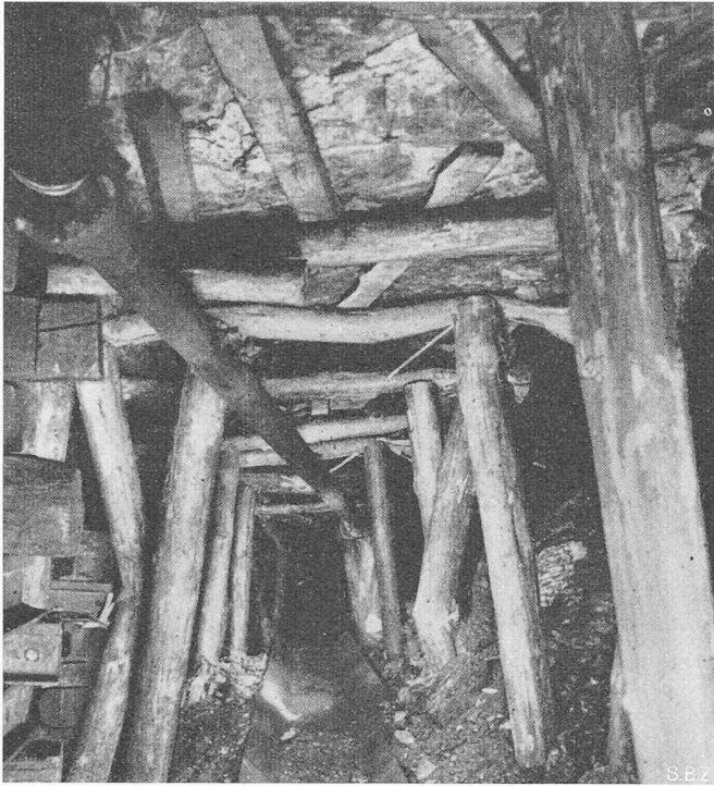
Bild 7. Rutschenstreb mit Holzausbau
