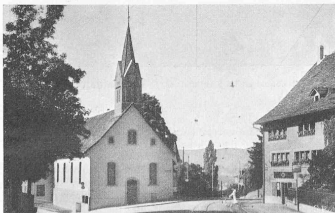
Bild 1. Kirchlein Fluntern vor der Renovation
