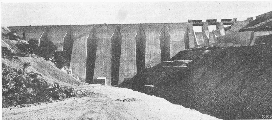
Bild 21. Staumauer Bau Muggeris, luftseitige Ansicht der 60 m hohen, im Herbst 1949 fertig erstellten Pfeilerstaumauer
