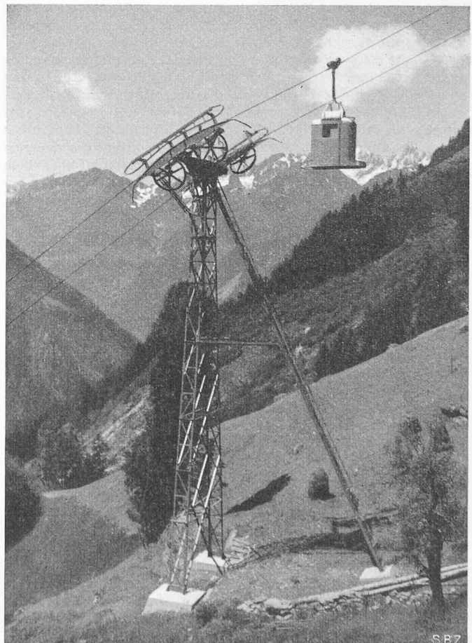
Bild 3. Stütze der Einseilbahn Bristen-Golzern, Kanton Uri
