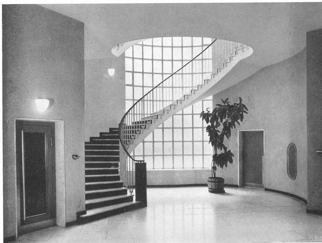
Bild 8. Eingangshalle im Erdgeschoss
