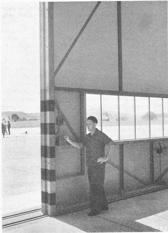
Bild 5. Torbedienung am Schalthebel
