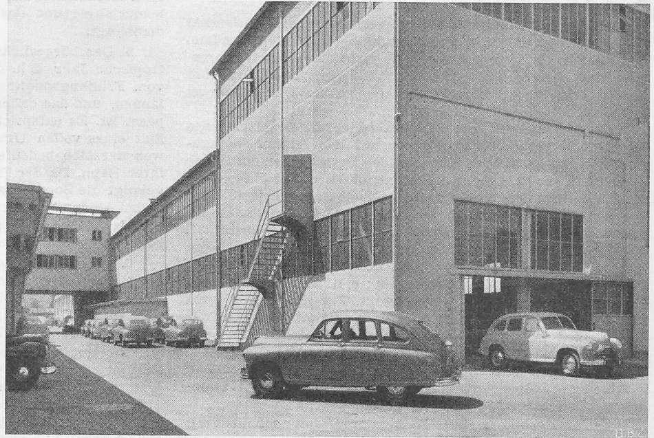
Bild 17. Blick aus Norden. Ausfahrt der fertig montierten Wagen
