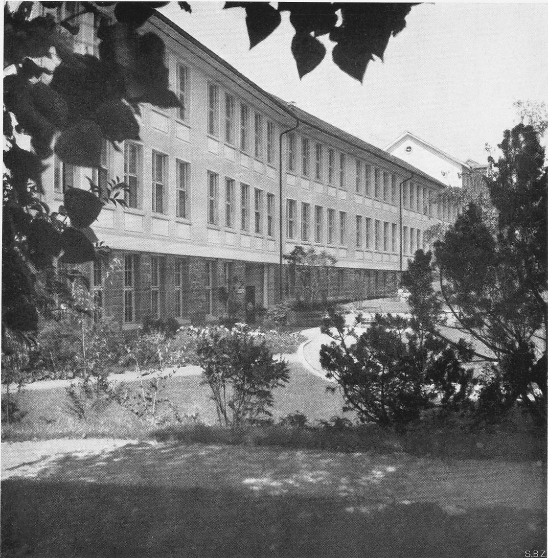
Bild 16. Ansicht des westlichen Klassenflügels aus Süden
