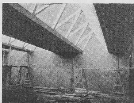
Bild 4. Das Dach von unten
