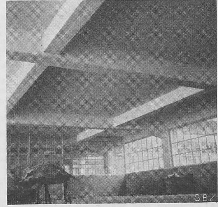
Bild 11. Trägerrost-Decke
