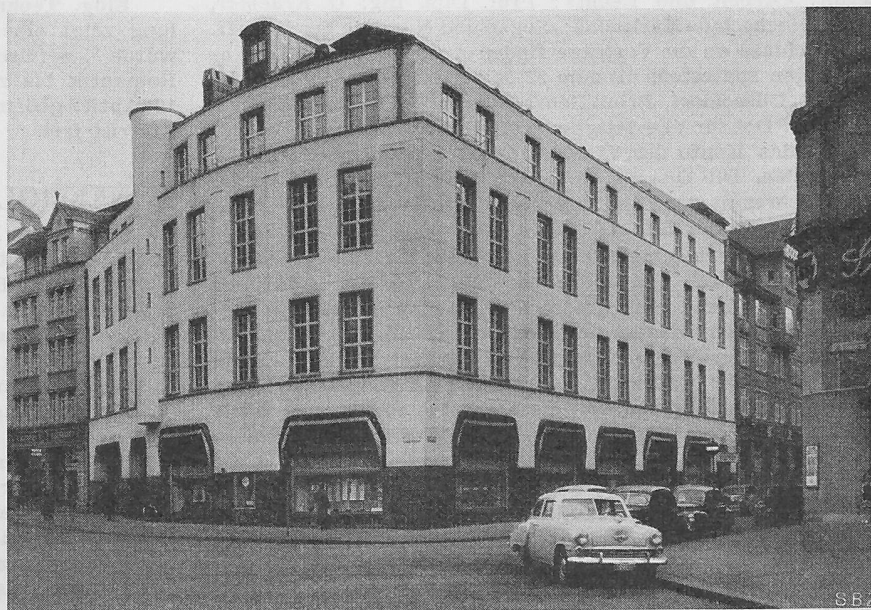
Bild 5. Telephonegebäude Fusslistrasse, 1925, Arch. PFLEGHARD & HAEFELI
