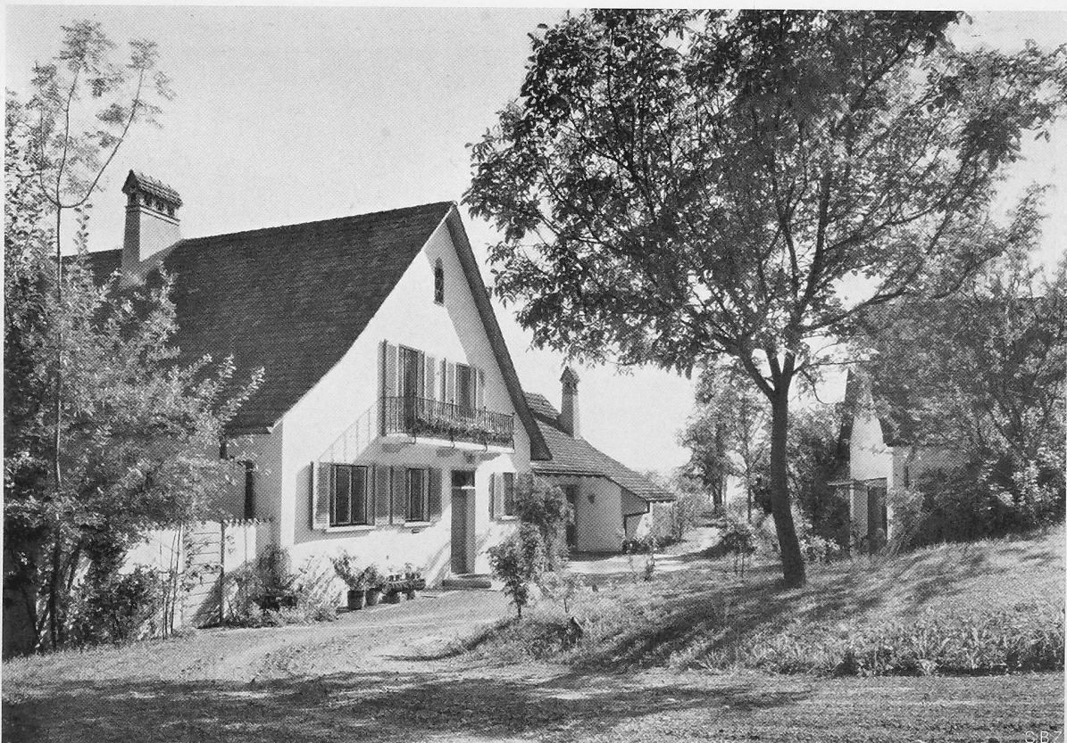
Bild 7. Eingangspartie aus Nordosten, rechts die Garage
