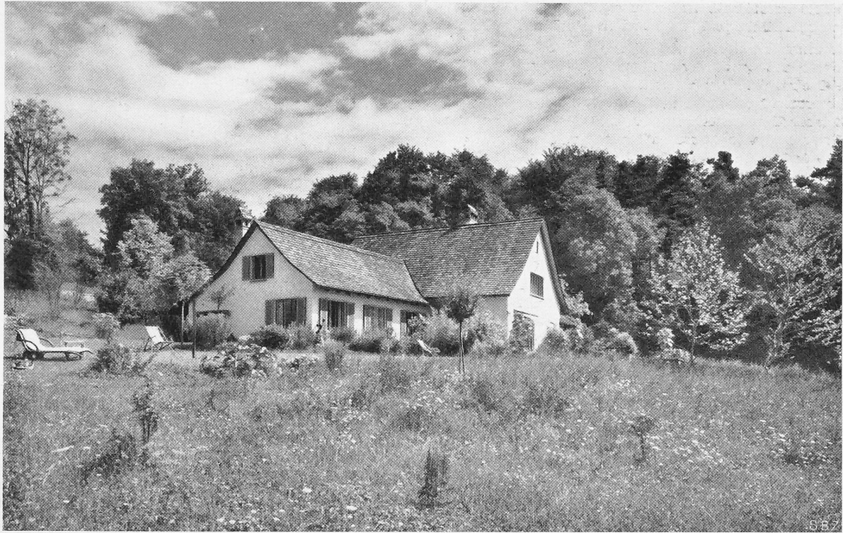
Bild 6. Ansicht aus Südwesten
