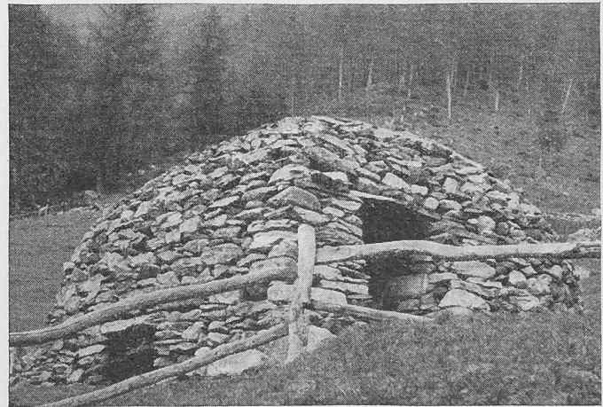
Bild 6. Rundbau auf Alpe Braga, südöstlich Viano, 1700 m ü. M. mit Aufteilung des Innenraums in Stall und Scheune (funktioniert als Casa rustica)
