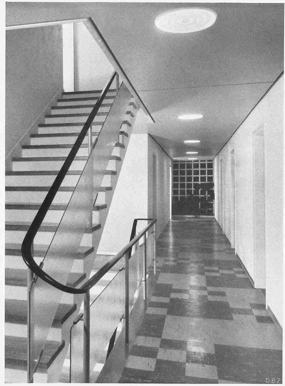
Korridor und Treppe im 1. Obergeschoss. Bodenbelag schwarze und hell- graue Asphaltplatten. Wände weiss, Decke hellblau. Treppengeländer: Handlauf schwarz, Stützen rot, Drahtglas
