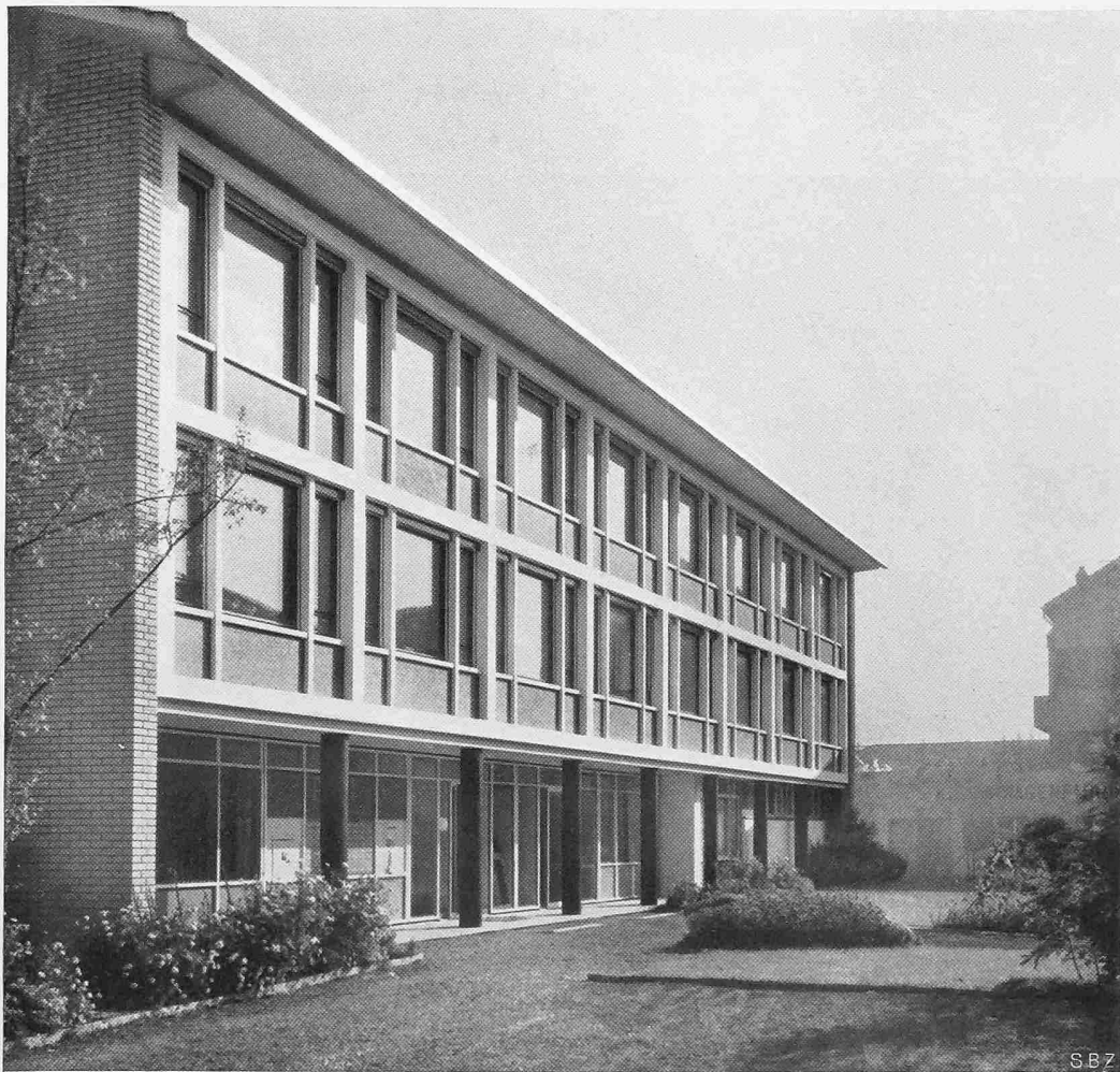
Ansicht des Gebäudes von der Strasse her. Betonraster und Kunststeinfeiler weiss, Brüstungen in den Obergeschossen dunkelgrau, im Erdgeschoss helles Blaugrün, Säulen schwarz
