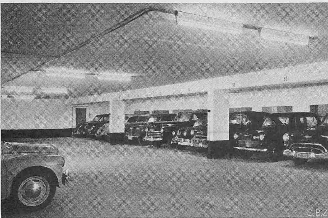
Bild 7. Garageraum mit bergseitigem Unterzug und Boxenreihe
