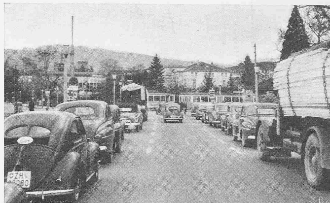
Bild 9. Dreispurige Vorsortierung in der landseitigen Längsfahrbahn des Platzes, Richtungsbezeichnung der beiden Spuren rechts und in der Mitte mit gleicherweise nach rechts abgewinkelten Pfeilen ergibt keine eindeutige Orientierung
