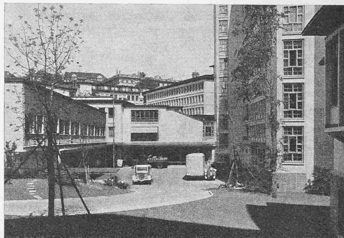
Bild 26. Hof mit Warenannahme, links Radiotherapie und Garagen, rechts Bettenhaus West (Blick gegen Nordosten)
