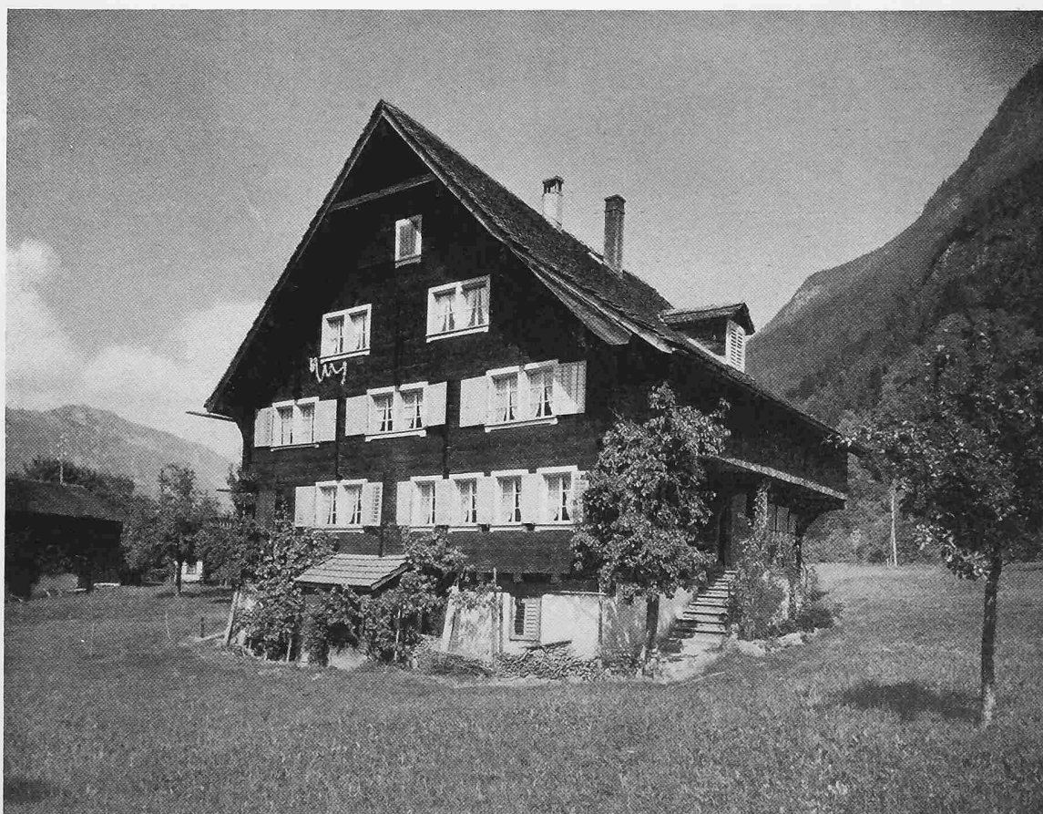
Haus in der Balmermatte in Bürglen, erbaut 1636, Südost-Fassade
